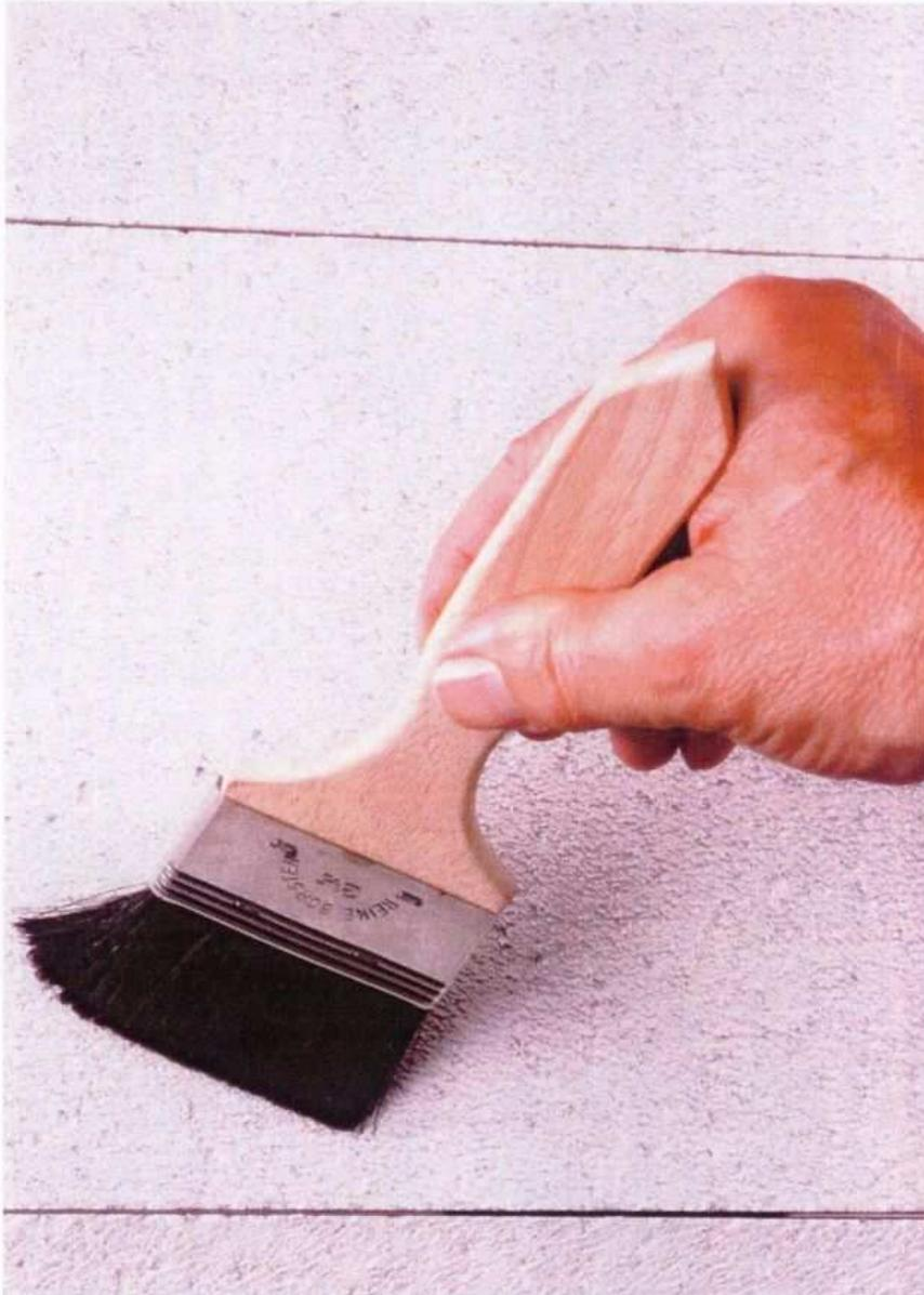
Entfernen Sie lose Teile / Staub etc. von der zu prüfenden Baustoffoberfläche mit Hilfe des Flachpinsels, so dass diese ausreichend tragfähig ist.
